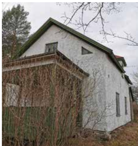
Rättaretorpet sett från vägen innan den revs.
