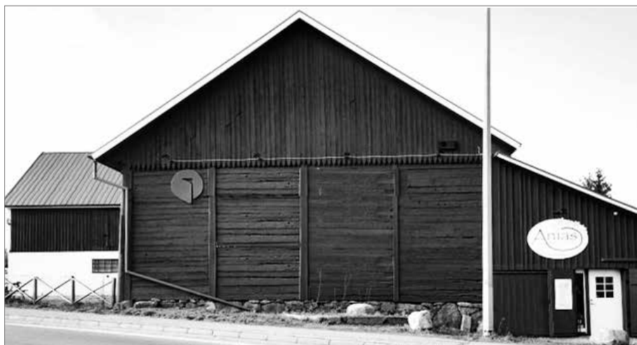
Den knuttimrade ekonomibyggnaden är en del av Ekerö kulturarv. (Foto Håkan Svensson)
