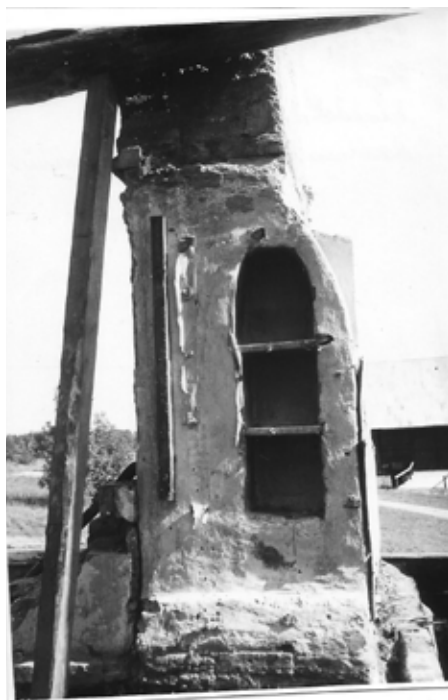
Under rivningen, augusti 1951
