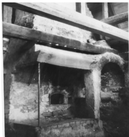
Bagarstugan byggs upp igen, oktober 1951
