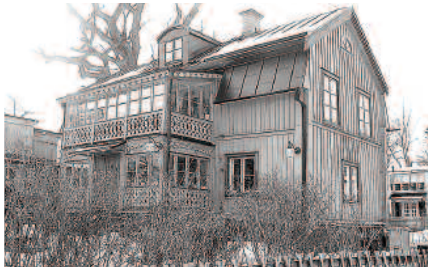
Platserna i Fattigstugan på Malmen fördelades rättvist mellan Drottningholm och övriga Lovö socken. Då bestod den nog bara av bottenvåningen med de mindre fönstren. Övervåningen med större fönster och verandan med snickarglädje mot trädgården tillkom under 1800-talets andra hälft då stugan blivit sommarnöje.
