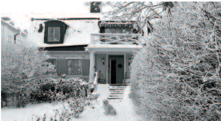
Lilla skolan eller som huset också brukar kallas Snickarbostället. Drottningholms småskola från 1843 till 1930 - talet då det byggdes om till bostadshus.
