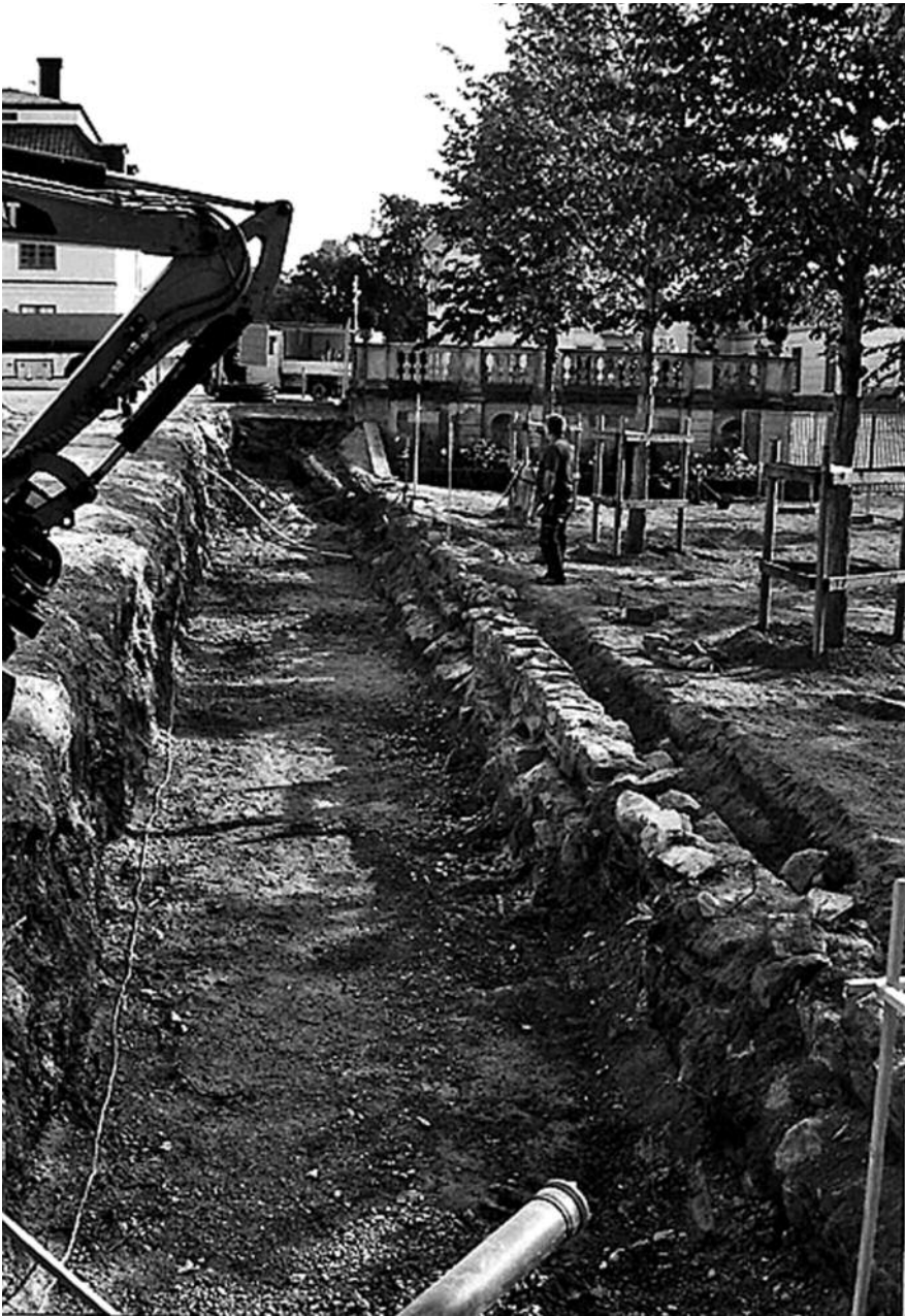
Bild 1: Norra Lindallén, schakt med grundmur, översikt mot öster.
