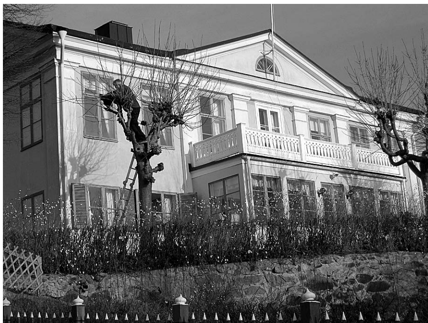
Robertshills framsida har balkong med veranda, som byggdes in i början av 1900-talet. Samtidigt försågs den bakre, norra sidan, med balkong och utbyggd entré.
